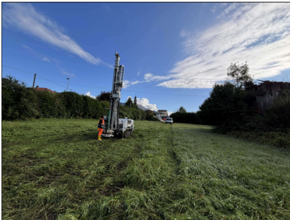
Ubicazione sondaggio S1
