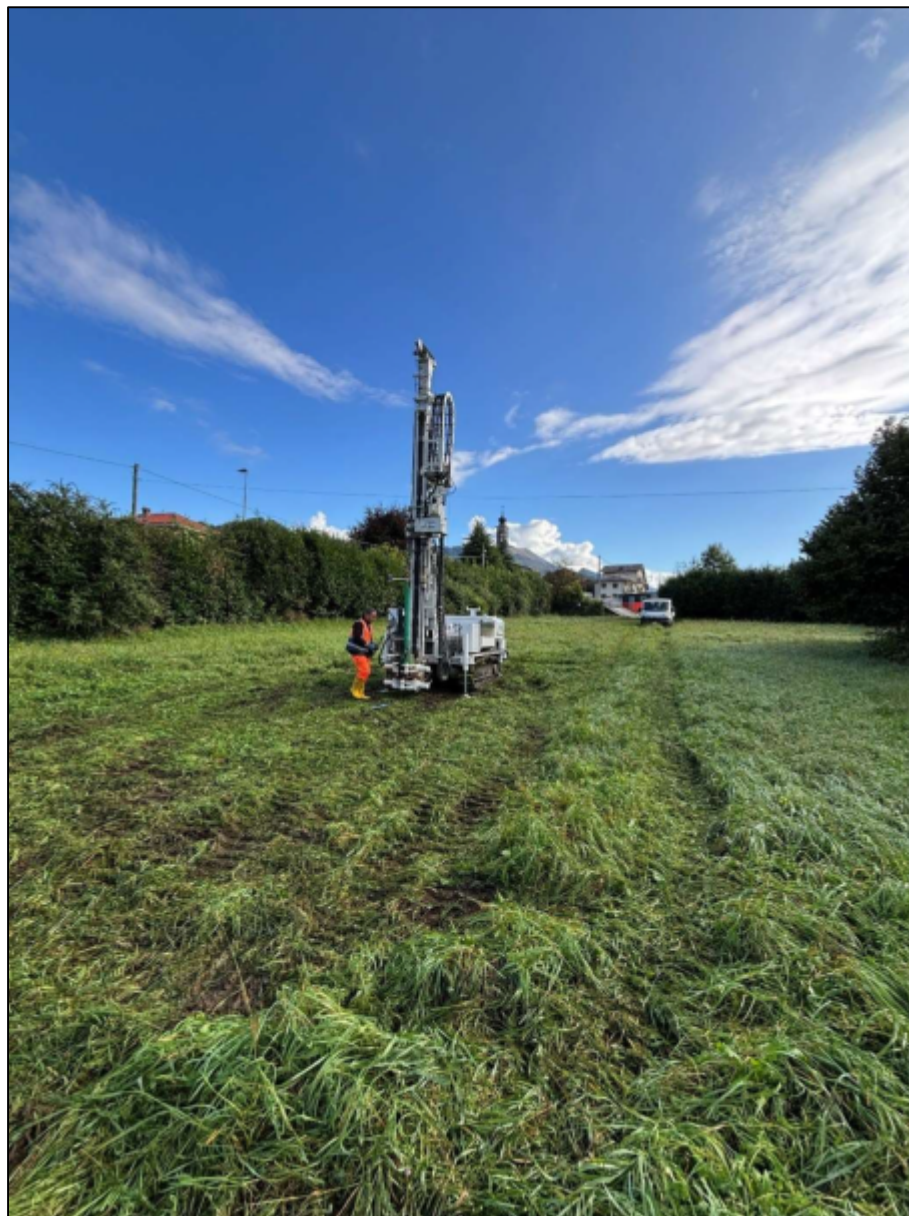
Figura 24 – Esecuzione del sondaggio S1
