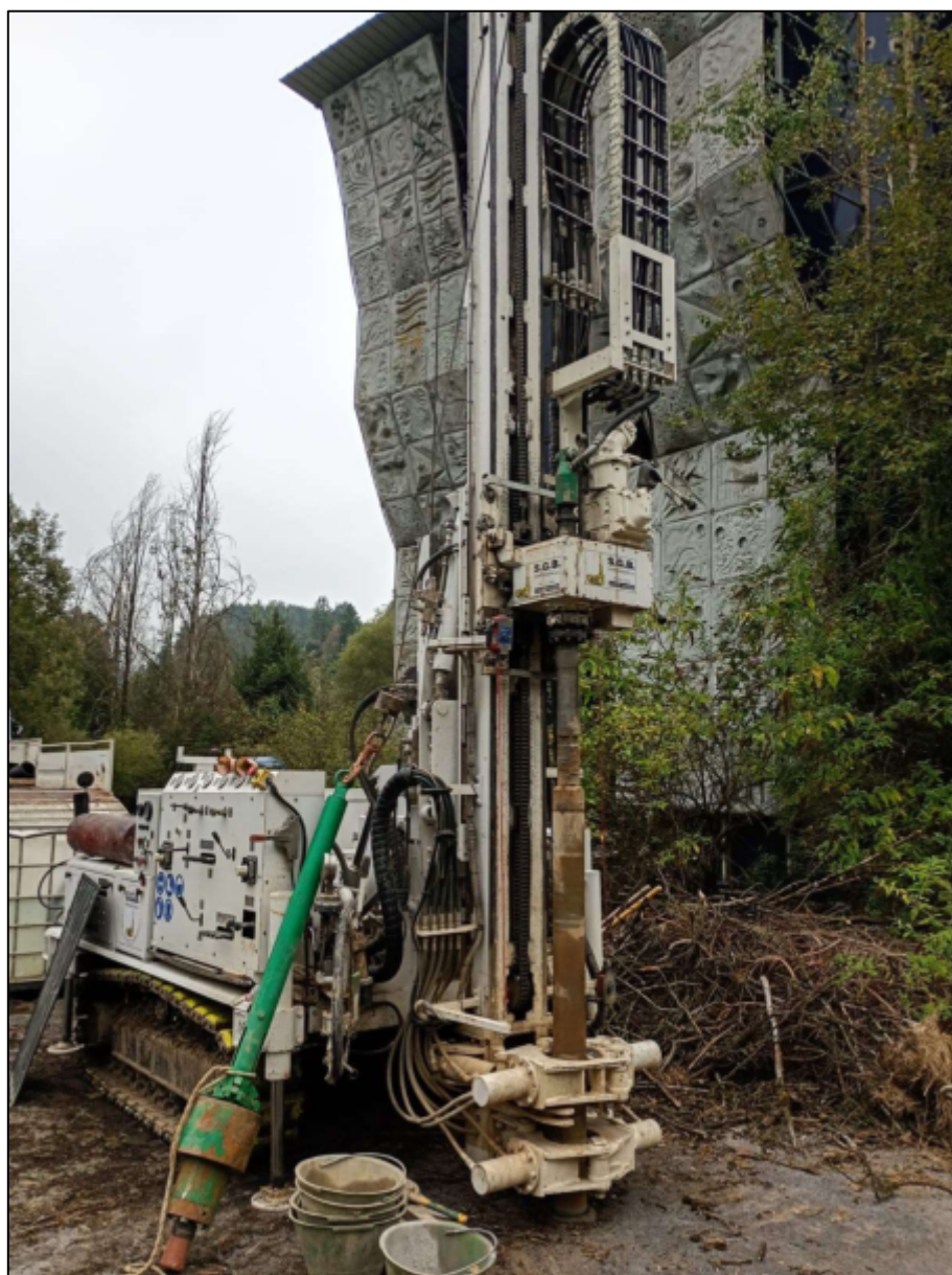
Figura 32 – Esecuzione del sondaggio S3
