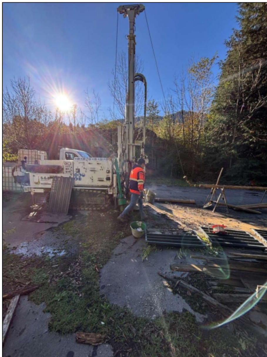
Figura 28 – Esecuzione del sondaggio S2
